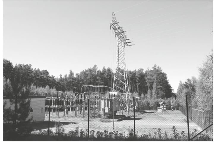
*Etwa so wie dieses Umspannwerk in Seddin wird das Golmer Umspannwerk aussehen. Von rechts wird aus dem 110 kV Netz Hochspannung eingespeist und im Umspannwerk mittels Transformatoren auf die notwendigen Mittelspannungen für die Haushalte von 10 kV und den Wissenschaftspark von 15 kV umgespannt.*
